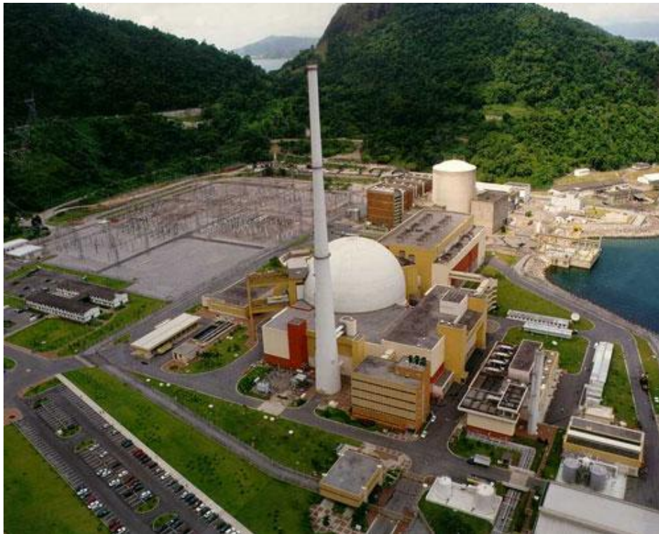
Vista de la Planta Nuclear Angra II. Capacidad 4014 MW. Brasil
